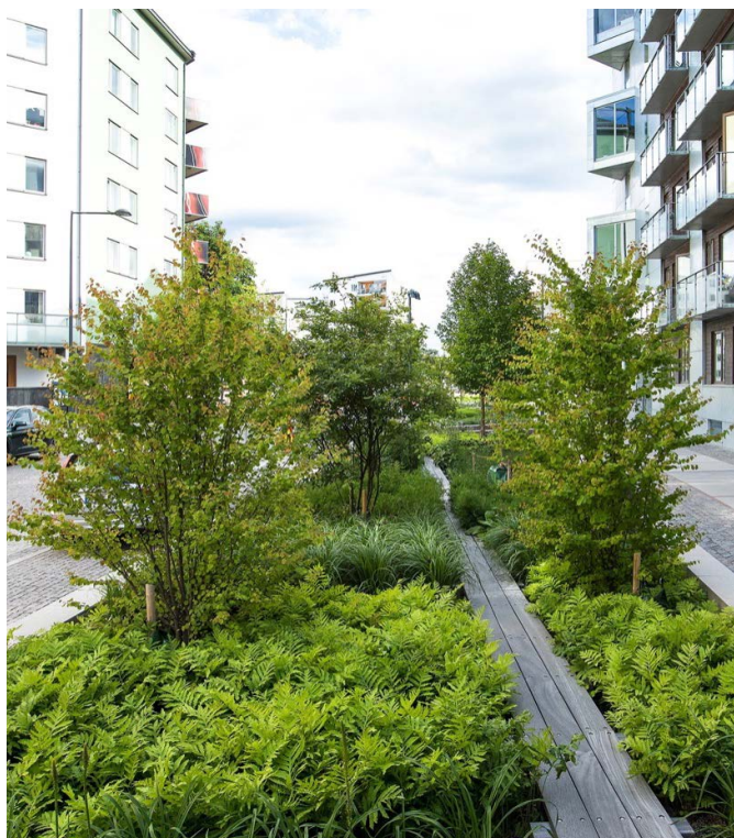
Obrázek 4 Příklad zasakovacího pásu se zelení, do kterého se svádí a na místě zasakuje dešťová voda, ulice Jaktgatan and Lovannsgatan, Švédsko, zdroj: https://landezine.com/
